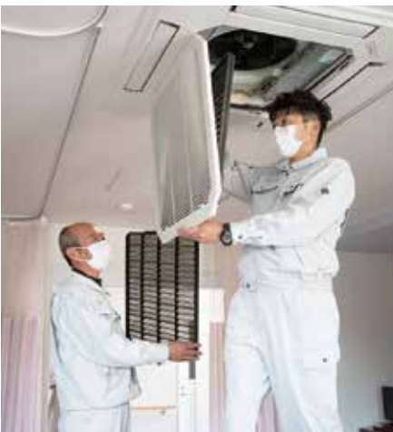
エアコンのフィルター交換
